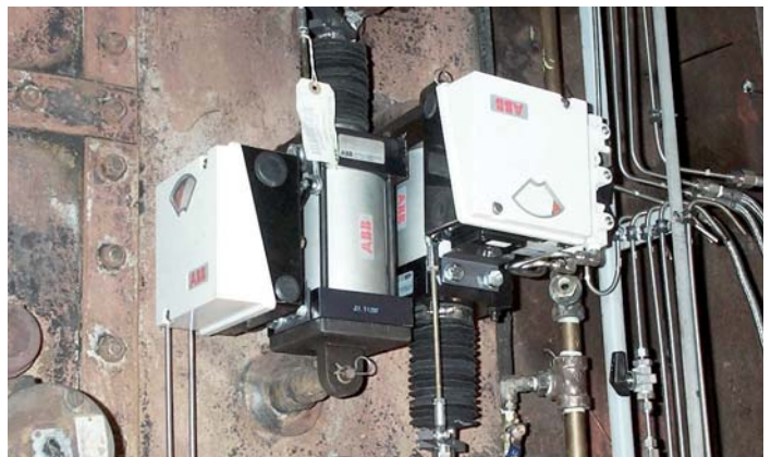
LP20 linear pneumatic actuator with AV positioner on a damper
